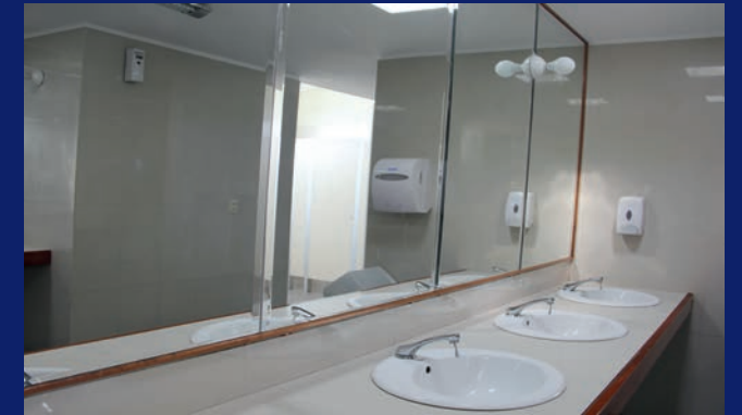
INSTALACIÓN DE PILETA ILUMINADA
